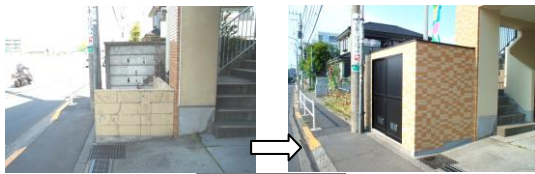
ゴミ置場改修
